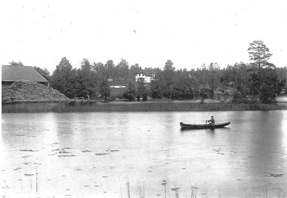
Zittra-Lasse är ute på en roddtur i sjön Flaten. Det vita huset i backen är Sandsta – hans hem och hans fabrik. T.v. stora kollhuset i Sandudden där Zittra-Lasse tidigare arbetade. Huset revs omkring 1929-30. Huset var över 70 m långt.
