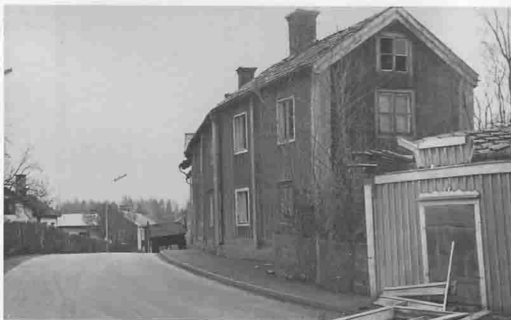
"DET ÄR BILLIGARE ATT RIVA ÄN ATT LAGA"
